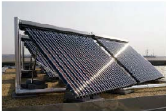
Figure 7: Solarni sistem z izpraznjenimi toplotnimi cevmi v Pentagonu je največji solarni toplotni sistem te vrste v severni Ameriki z nominalno največjo toplotno močjo 75,6 kW.
