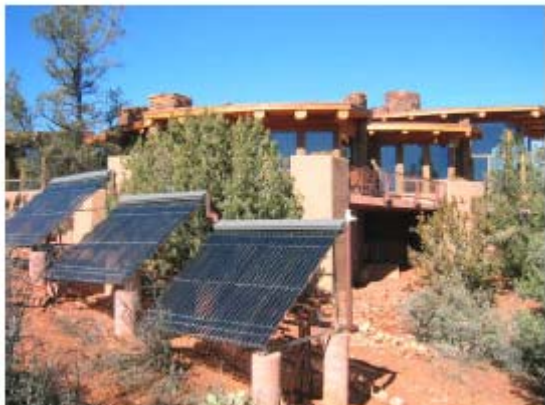
Slika 9: Sistem sončne termične energije z močjo 6,3 kW prikazan zgoraj v Sedoni v Arizoni je glavni vir ogrevanja prostora.
