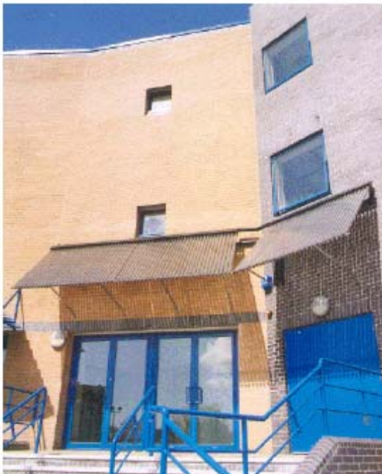
Slika 6: Fleksibilnost in nizka odpornost cevi Thermomax na veter ponujata edinstvene oblike. V zgornji instalaciji so uporabljene kot krilo.
